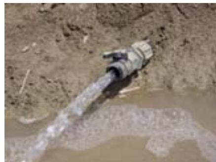
I requisiti della pressione di lavaggio sono influenzati dalle variazioni di elevazione e dalle perdite di carico nel gruppo dei tubi di lavaggio interrati.
